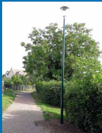
Les lampadaires, à LED, ont une veilleuse de base, plus une cellule avec détection de présence qui déclenche un éclairage à pleine puissance.
